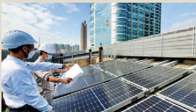
安裝太陽能電池板
