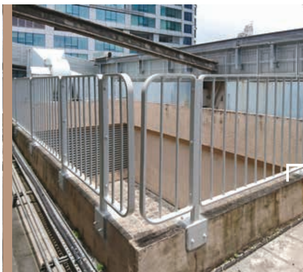
在屋頂安裝的防護欄
